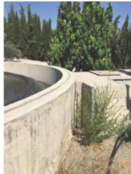
29.- Acceso arqueta. Colocar escalera portátil para el acceso, señalar riesgo de caídas, y en la parte de arriba de la arqueta, colocar barandillas de protección. RIESGO MODERADO.
