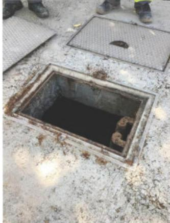
28.- Proteger unión de arqueta caudalímetro con decantador. Riesgo caídas. Colocar barandilla. Indicar riesgo mediante señalización. RIESGO IMPORTANTE.
