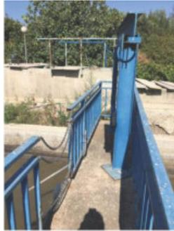
21.- Riesgo golpes en la cabeza, con el pórtico existente en el puente del biológico. Señalizar y proteger. RIESGO MODERADO.
