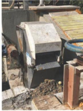
24.- Colocar barandilla en esta zona o realizar el trabajo sin subirse al muro del reactor biológico. Riesgo caídas. Flotadores. RIESGO INTOLERABLE.
