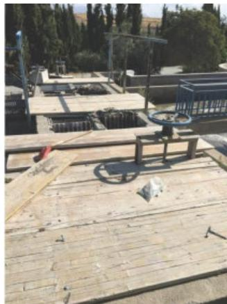
11.- Enclavar acceso al silo espesador de fangos, colocar señalización de prohibido subir, solo se podrá acceder aplicando el procedimiento de trabajo en altura. Entregar procedimiento trabajo en altura a los operarios. RIESGO IMPORTANTE.
