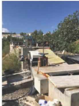
23.- Mecanismo de extracción de residuos de desbaste sin proteger partes móviles. Sin señalización de riesgo atrapamiento. Sin paro seguridad. RIESGO IMPORTANTE
