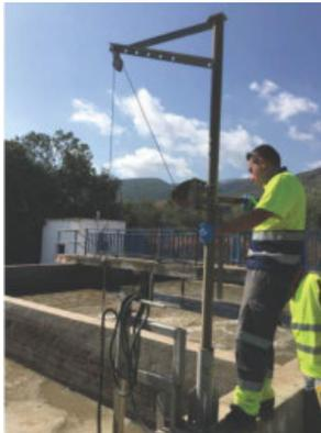
25.- Muro biológico, en esta zona tiene poca altura. Colocar barandilla para evitar caídas, en el tramo en el que no llega a la altura necesaria (90 cm). RIESGO IMPORTANTE.
