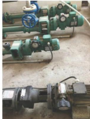
19.- Poner una cadena en lugar de cuerda en la bomba del biológico, para facilitar su extracción para mantenimiento, en caso de averías, etc. RIESGO MODERADO.
